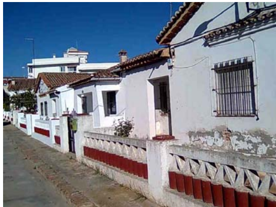
Los cerramientos de las parcelas ( teja ornamental y celosía superior en forma de rombo)
