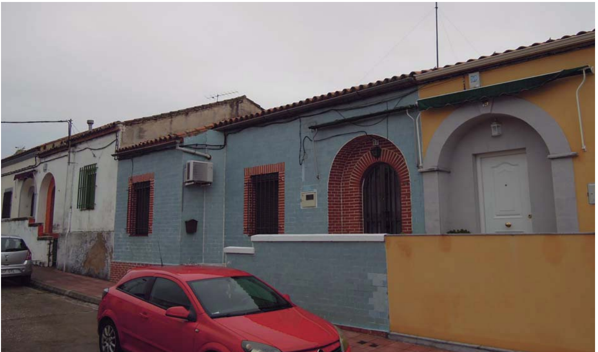
Fotografía 8: Revestimiento de fachada con azulejos
