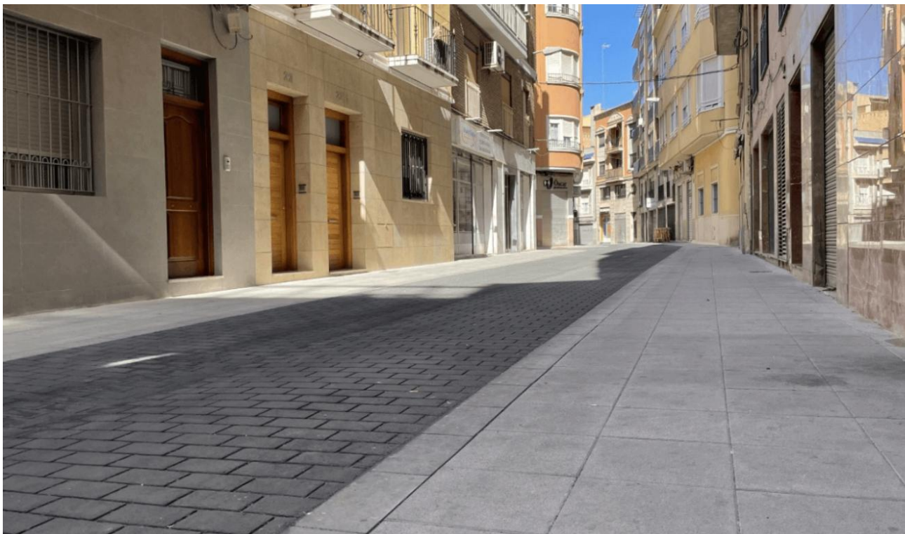
Fig 61. Transformación de viario a plataforma única. Fuente: Ayuntamiento de Elche
