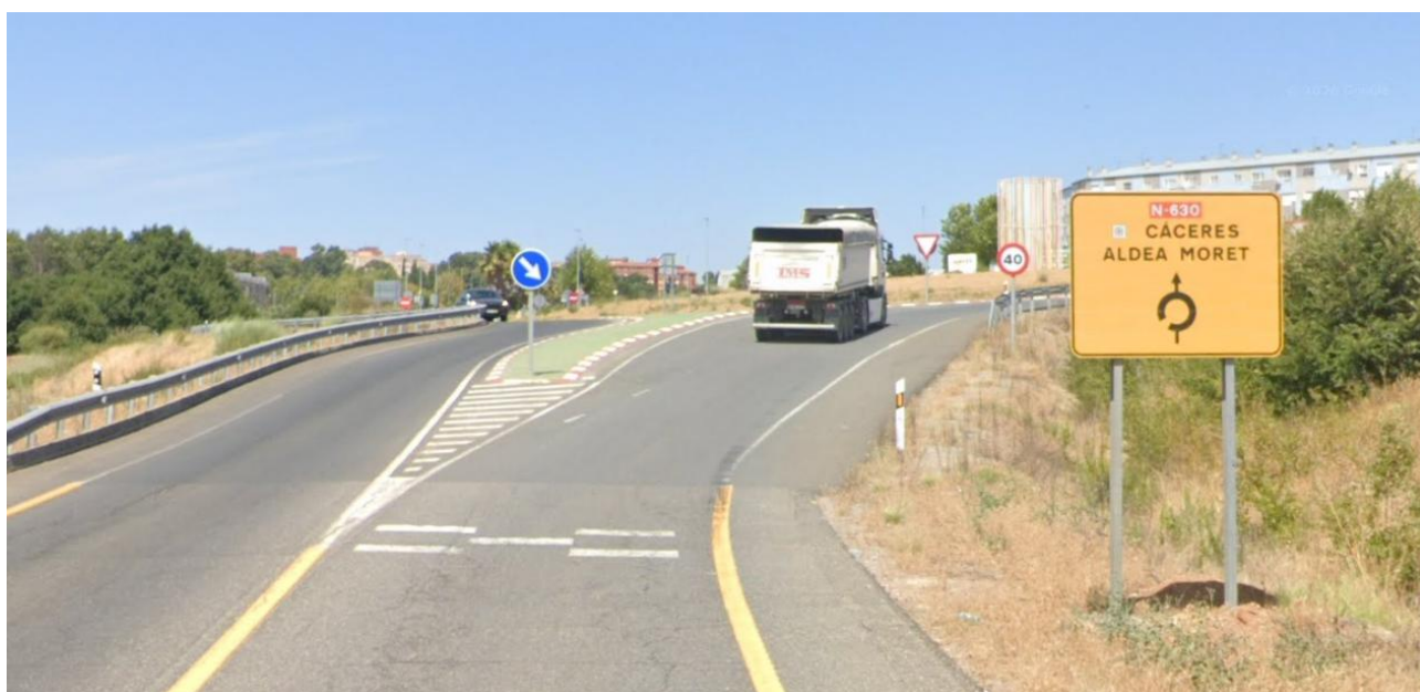
Fig 13. Enlace de acceso al municipio desde la N-523
