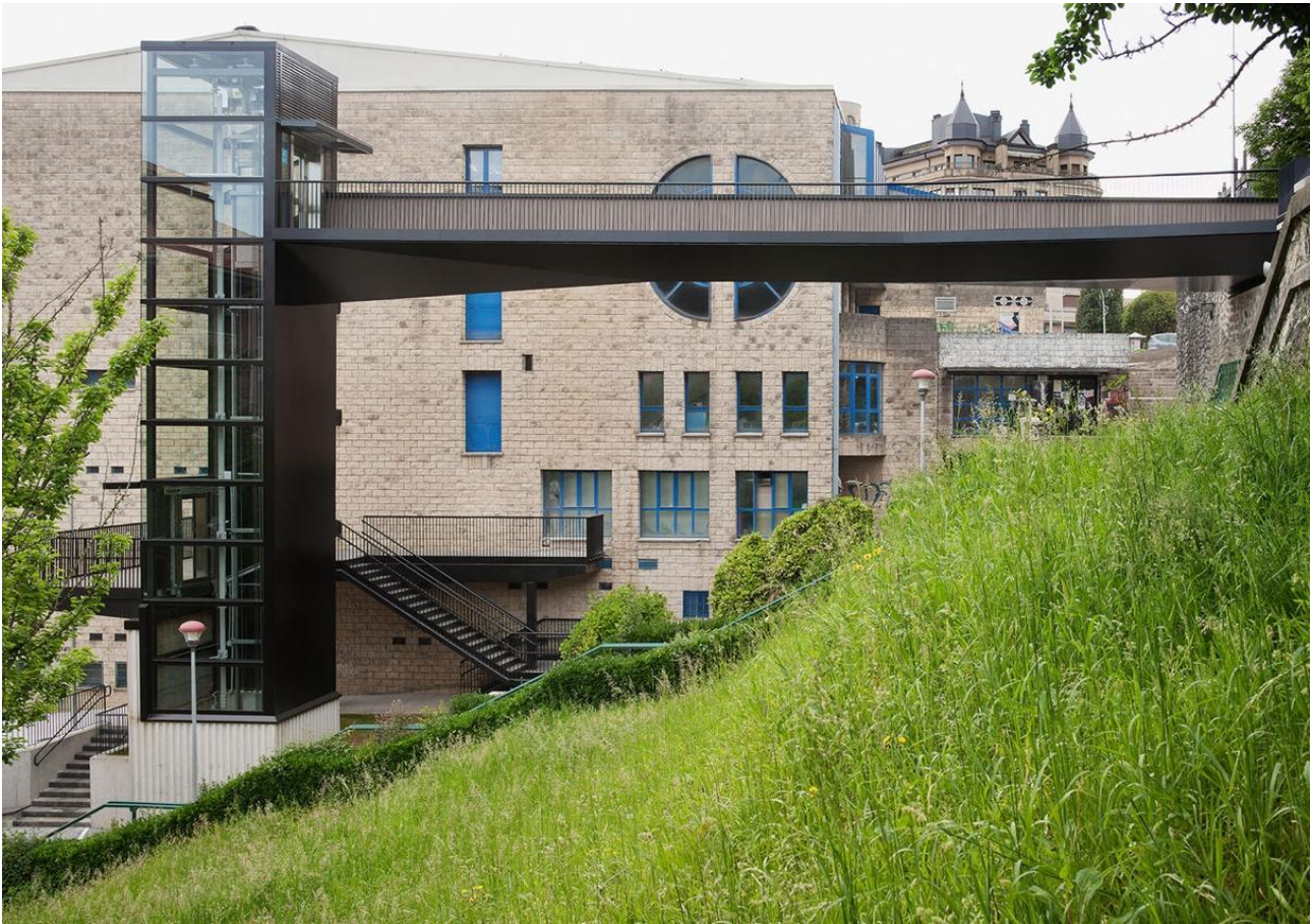
Fig 58. Ascensor y pasarela. Hernani. VAAUM Fuente: ArchDaily.
