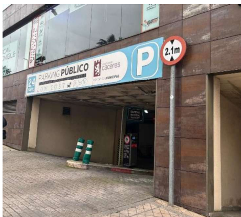
Fig 137. Entradas aparcamiento El Perú. Fuente: Elaboración propia
