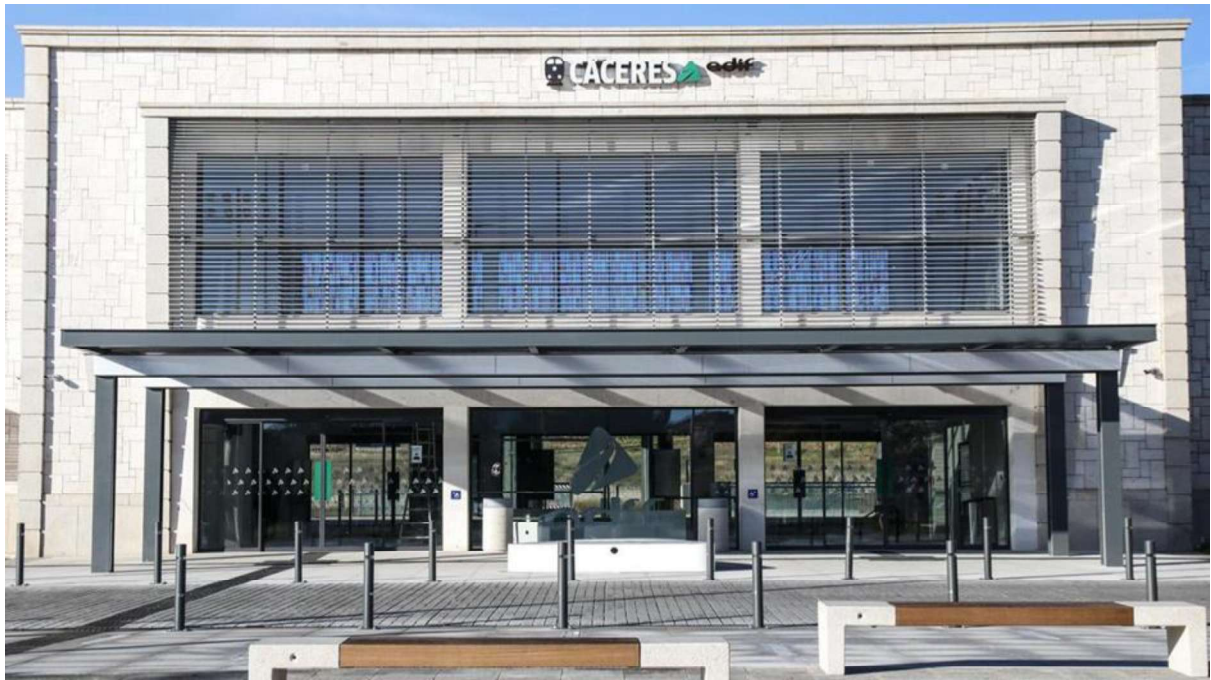
Fig 101. Estación de tren de Cáceres. Fuente: Elaboración propia
