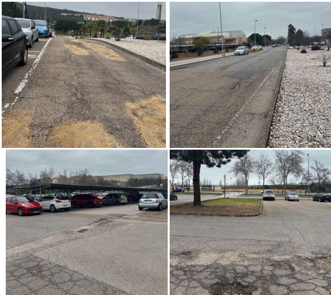
Fig 222. Pavimento zona Campus Universitario. Fuente: Archivo propio
