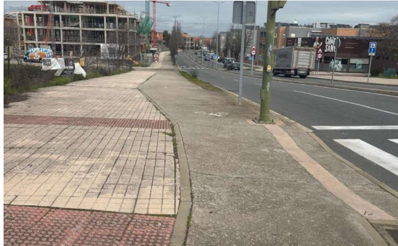
Fig 183. Acera bici Cardenal Hernandez. Fuente: Archivo propio
